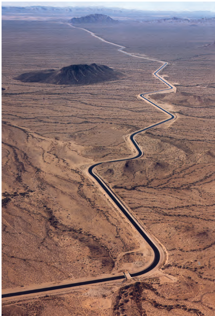
CAP zig-zag canal. Source CAP
