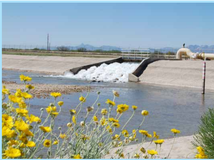
Central Arizona Project Recharge Basin in Tucson. Source: Rodolfo Peón.
