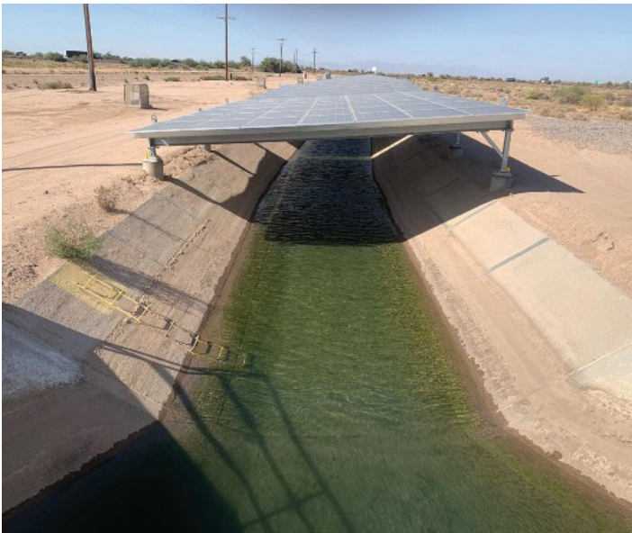
Proyecto solar del GRIC: paneles solares sobre los canales. Fuente: Northeast Valley News
