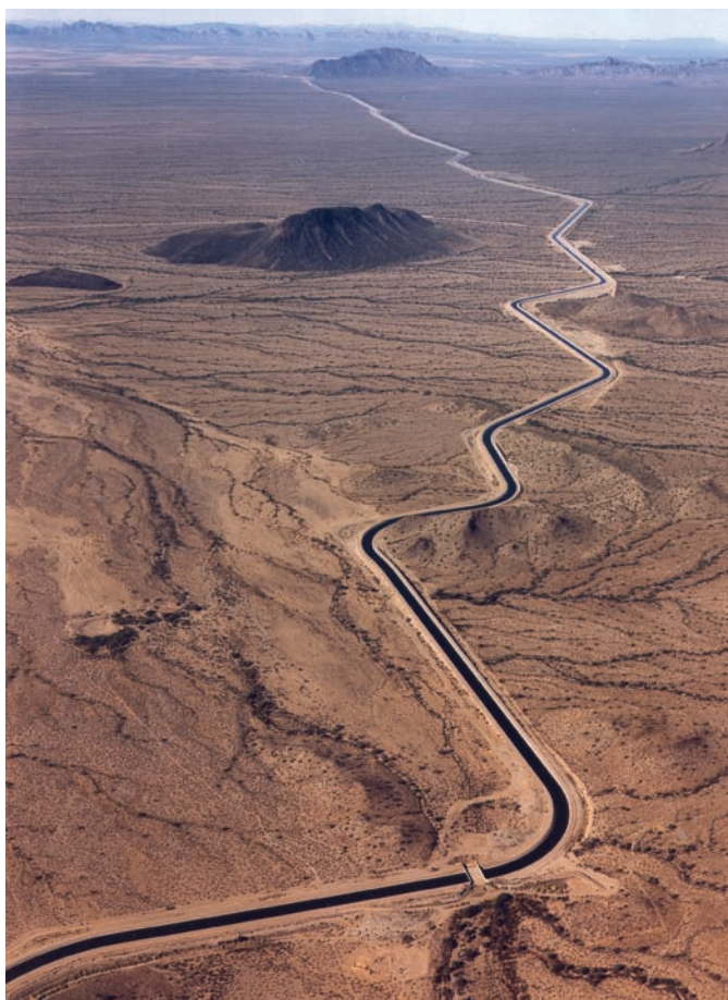
El canal del Proyecto del Centro de Arizona (CAP) en forma de zigzag. Fuente: Proyecto del Centro de Arizona (CAP).
